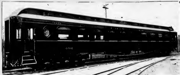
Fig. 3—Exterior View of New Cars, St. L. & S. F. R. R.
